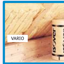
prawidłowo zaizolowana konstrukcja dachu
