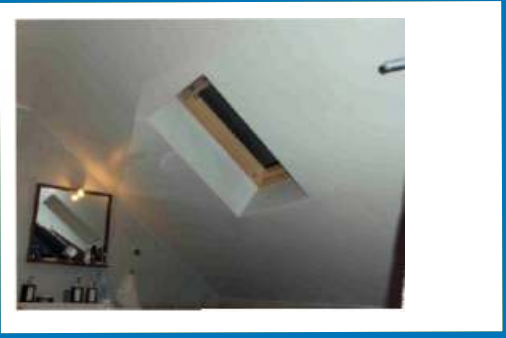
Mostki ciepłe w rejonie osadzenia okna – niezachowanie ciągłości izolacji termicznej między ościeżem a izolacją połaci dachowej.
